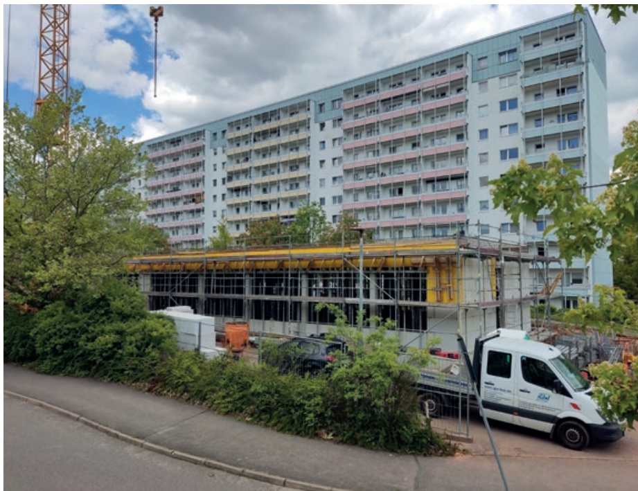
Aktuell sind die Bauarbeiten in vollem Gange.
