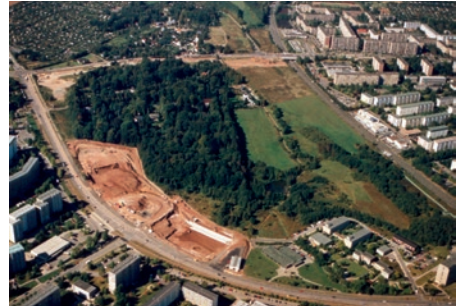
Erdarbeiten und Anlegen der Hauptfundamente für das Vita-Center 1997.
