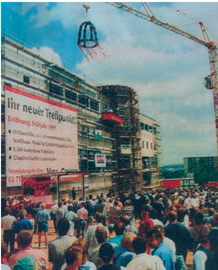
Großer Bahnhof beim Richtfest am 24. Juli 1998.
